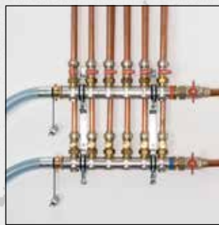
Proplachování radiátorů a plošných topných systémů (S/SL/SLW)
