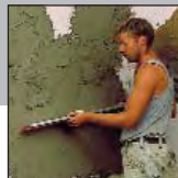
Typ TRK: Strhávání jádrové omítky.
